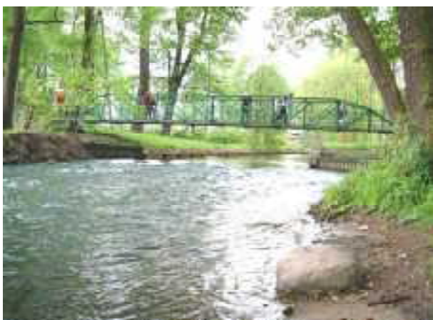
Fußgängerbrücke über die Fietze in Schöneck
